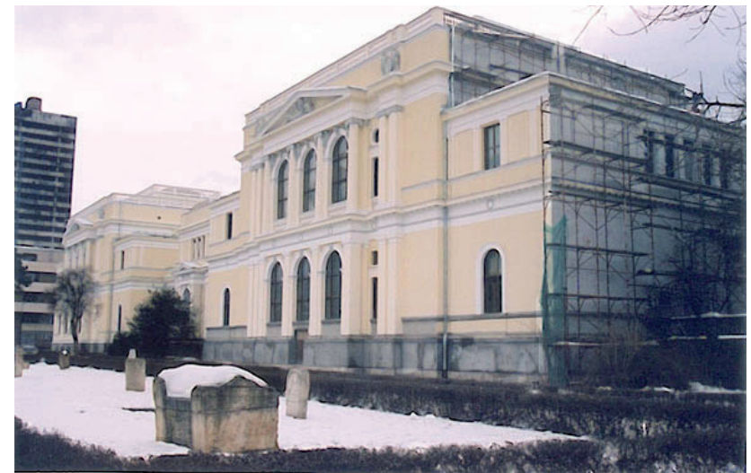
Zmajevski Muzej, under renoveringen, januari 2003 Foto: Kulturarv utan gränser
